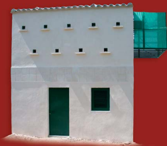
Bâtiment de libération
